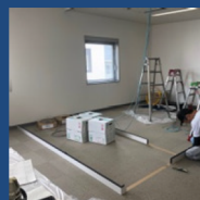
床/天井に墨出しを行い、 レールと支柱を取付けて
