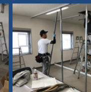
床/天井に墨出しを行い、 レールと支柱を取付けて
