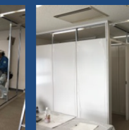
パネルを設置
